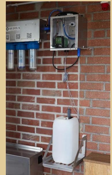
Anlage mit einer Dosiereinheit. Bis zu drei Dosiereinheiten sind möglich.
