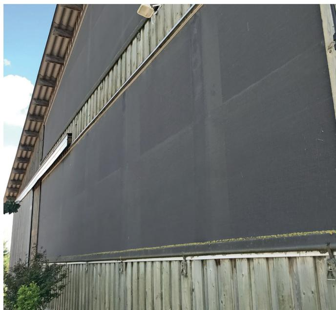
*Neben Fenstern sind auch Windschutznetze eine gute Lösung, um Frischluft ins Innere von Stall oder Reithalle zu bringen. Bei gutem Wetter kann man sie auch wie ein Rollo hochrollen.
